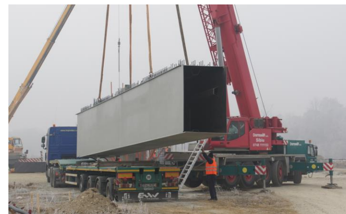
Pod Autostradă Simeria
