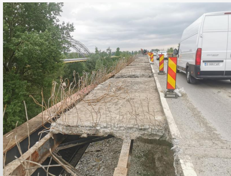
Figura 5 – Demolarea platelajului din beton armat
