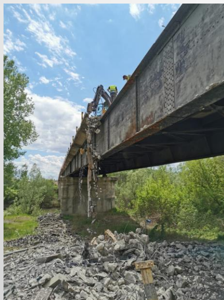
Figura 5 – Demolarea platelajului din beton armat
