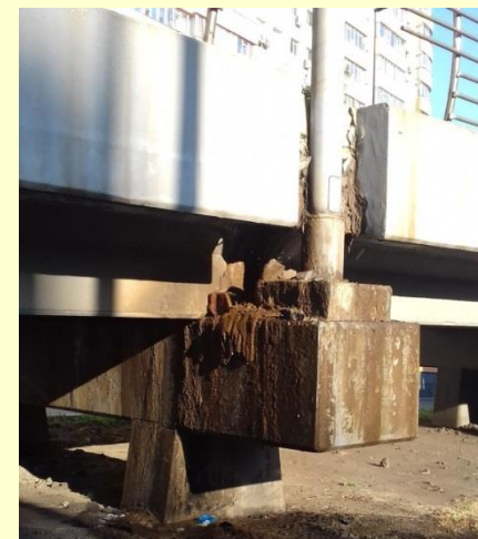
Figura 28 - Coroziunea prematură a armăturilor datorată atacului în XF4, XC4, XD3
