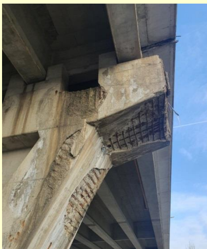
Figura 28 - Coroziunea prematură a armăturilor datorată atacului în XF4, XC4, XD3
